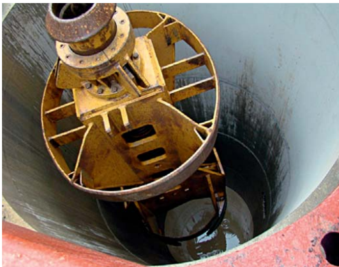
Применение МНБУ на проходке вертикальных стволов
