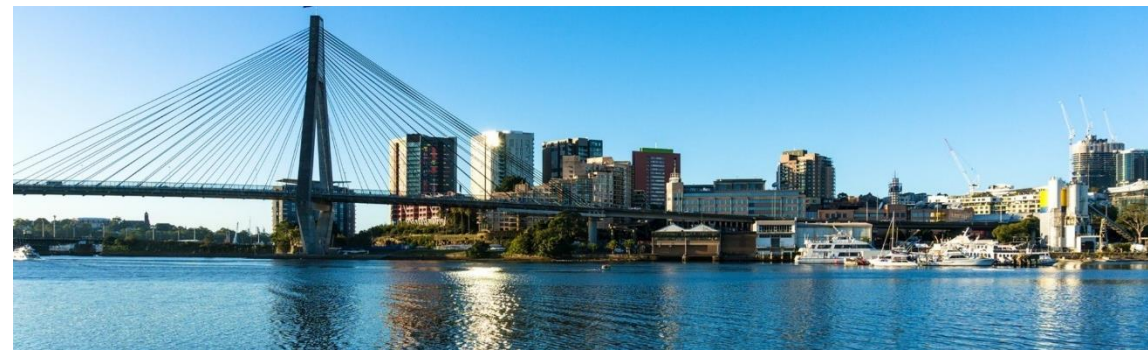
Организация инфраструктуры и гражданское строительство
